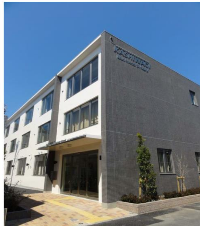
耐震構造 3 階建てのきれいな校舎です。
